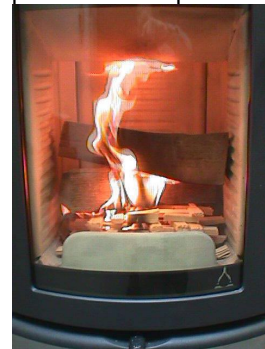
III. 3 : Chiusura presa dell'aria primaria
