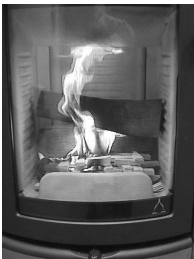
Ill.3 : Chiusura presa dell'aria primaria
