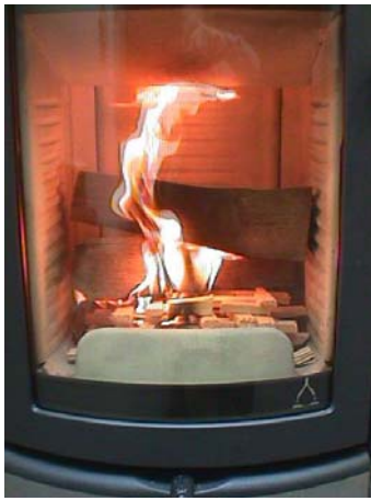
Fig. 5: Primärluftschieber schließen
