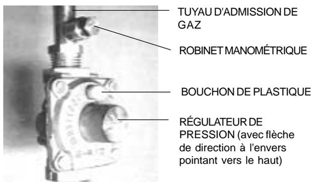
Fig. 5 - Installation du régulateur de pression du gaz
