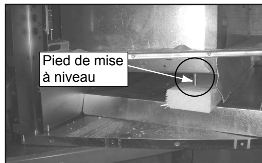
Figure 10.5. Veillez à ce que le pied de mise à niveau soit bien placé sur la pièce de bois de 50 x 100 avant de mettre l'encastrable à niveau.
