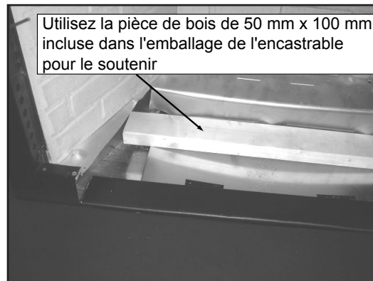
Figure 10.3. Si le sol est constitué d'une fine plaque métallique, nous recommandons d'utiliser la pièce de bois de 50 mm x 100 mm incluse dans l'emballage de l'encastrable pour le soutenir. Il peut être nécessaire de couper la pièce de bois de 50 mm x 100 mm aux dimensions appropriées.
