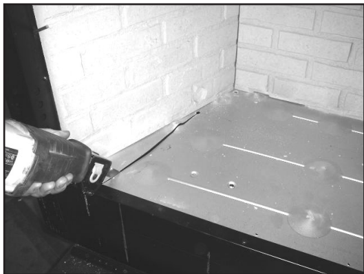
Figure 10.2. Au moyen d'une scie égoïne électrique, découpez la base.
