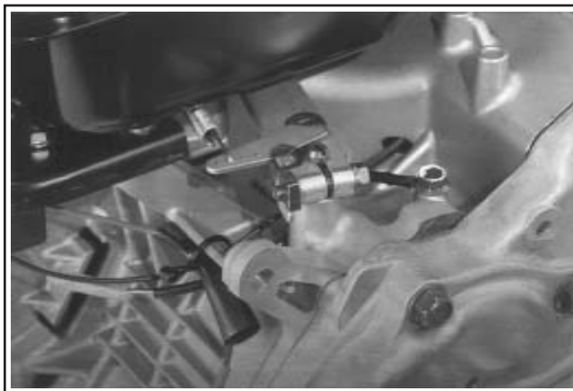
Figure 11-85. Emplacement du câble de terre CS8.5-12.
