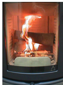
III. 3 : Chiusura presa dell'aria primaria
