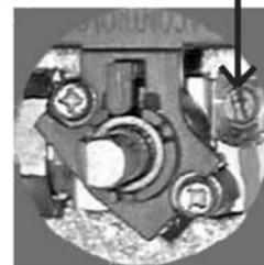
Vite del by-pass del bruciatore
