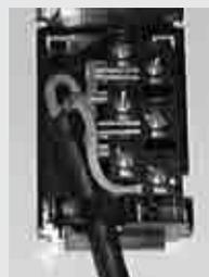
Attention : un mauvais serrage peut entraîner des risques d'échauffement dangereux au niveau du câble d'alimentation.
