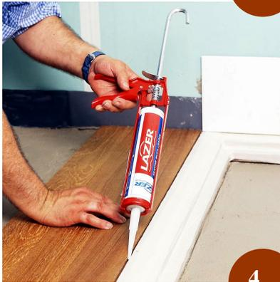
Réaliser un joint en utilisant de préférence le mastic LAZER Réf : 290311 sur la périphérie du module d'extension.
