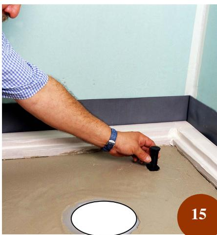
Ancrer les vérins en obturant la partie inférieure à l'aide des bouchons plastique fournis dans la chape encore fraîche conformément au plan fourni ci – après (voir page 7).
