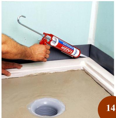
Réaliser un joint entre la périphérie du cadre et le mur à l'aide d'un pistolet à colle en utilisant de préférence le mastic LAZER Réf : **290311**
