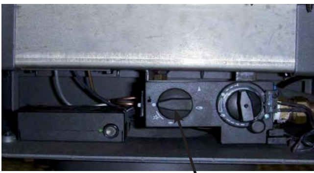
Empfänger und Gasreglerblock (A)
