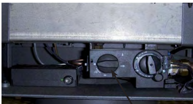
Récepteur et bloc de réglage du gaz (A)
