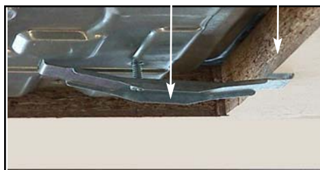
Patilha de fixação Bancada de trabalho
