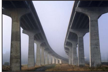
Après ajustement des niveaux automatiques combinés
