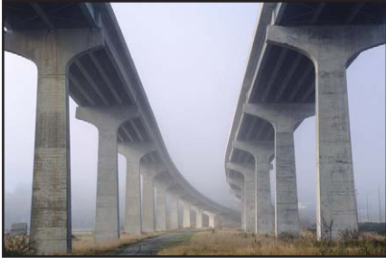
Avant ajustement des niveaux automatiques combinés
