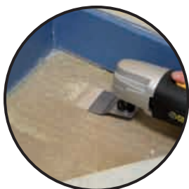
Creuser To dig
