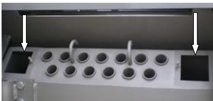
Photo 14: Ouvertures de nettoyage supérieures des conduits de fumée
