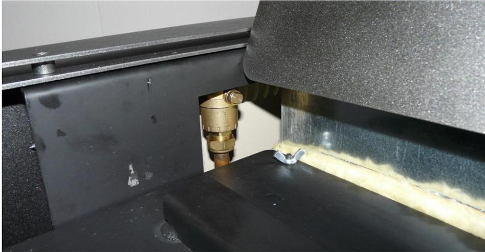
**Purge du circulateur :** Le circulateur est situé à l'arrière droite du poêle. Pour le purger, il suffit de dévisser l'écrou du purgeur automatique.
